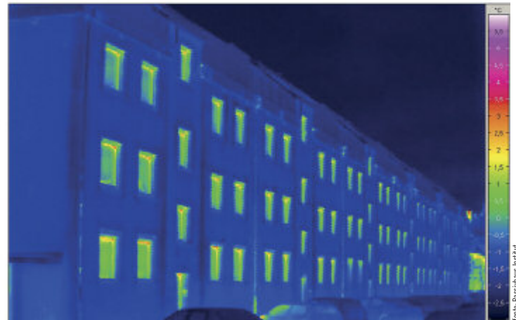
Edificio nella Tevesstrasse a Francoforte sul Meno (D), risanato con tecniche e parametri Passivhaus. In basso a sinistra, la termografia eseguita prima dell'intervento di risanamento, a destra la termografia eseguita sullo stesso edificio dopo i lavori di ristrutturazione.
