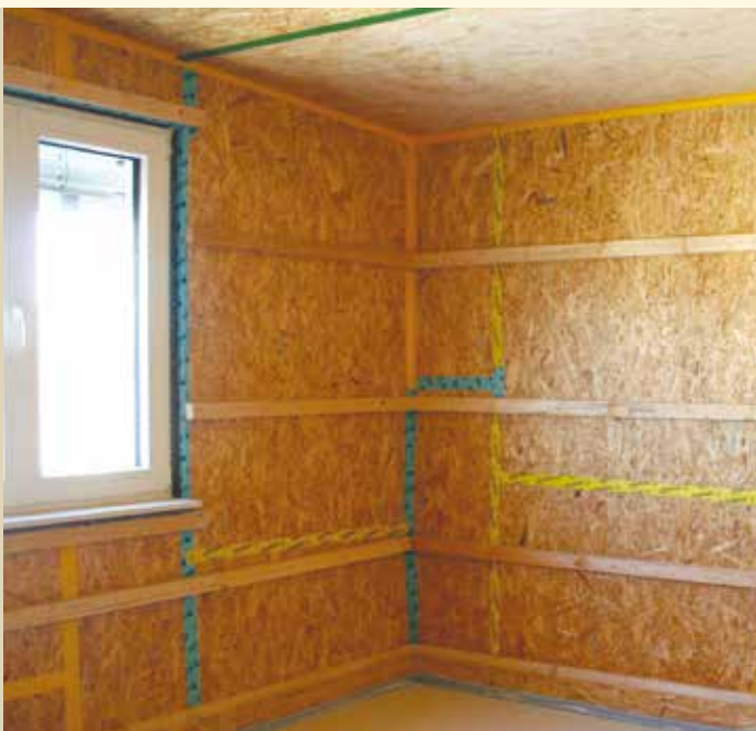
اتصالات هوابند بین بوردهای کامپوزیت چوبی
