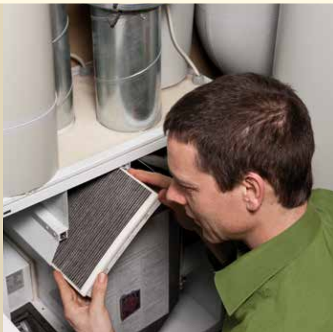
تعویض فیلتر سیستم تهویه
