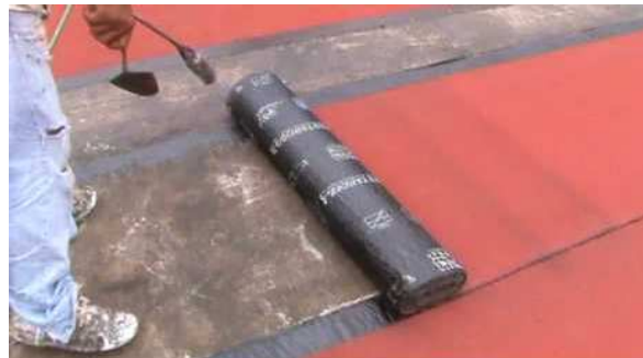
Techo Oscuro (bituminoso) Reflectancia \geq 5-10\% Emisividad \geq 90\%
