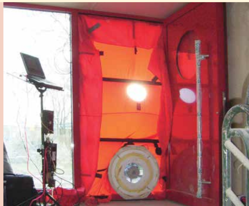
Ventilatore per il test Blower-Door
