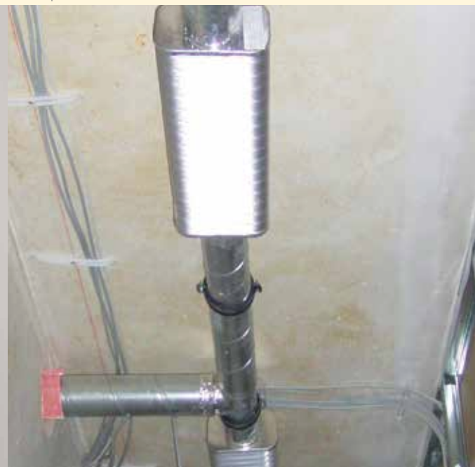
Canale per aria di mandata durante la fase di installazione
